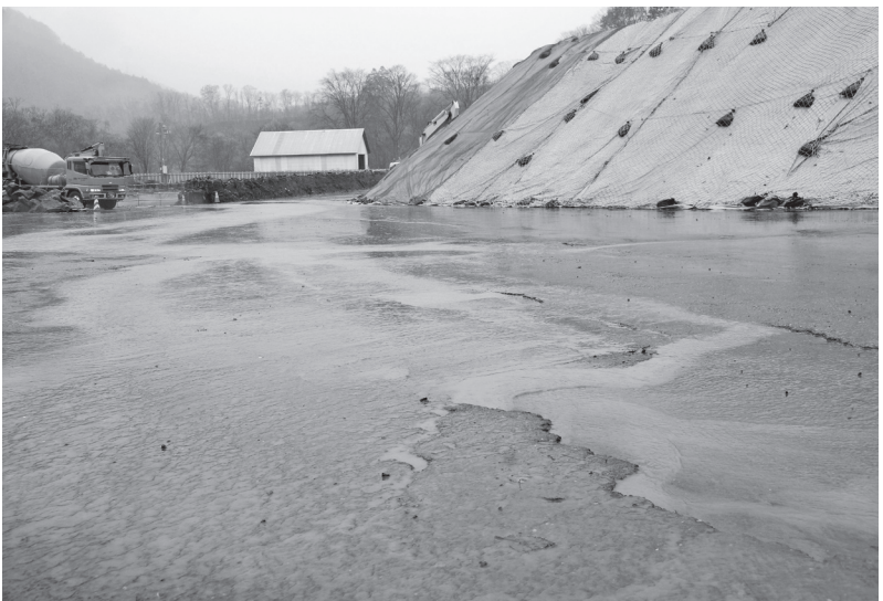
渡島トンネルの建設現場では、トンネル湧水が白濁して地面を流れていた。ブルーシートをかけているのは要対策土
