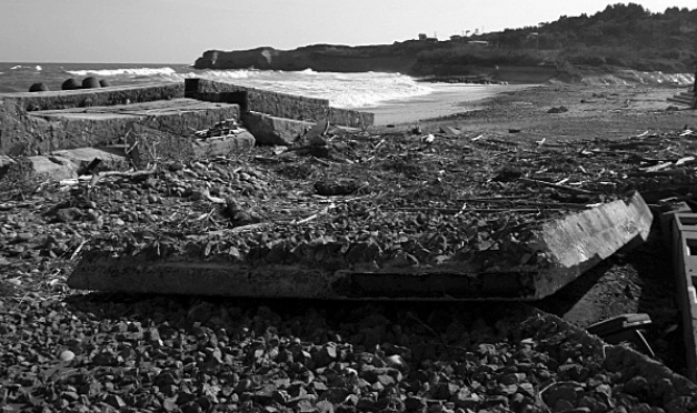
建物が根こそぎ消えた熊川地区の津波被害跡（大熊町役場提供）
